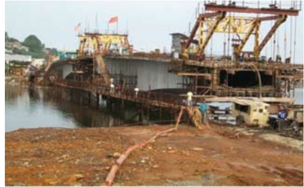
האי המלאכותי שנבנה בצד המערבי של הגשר (מימין) והגשר הקיים המחוזק ממזרח, שתוכננו כפלטפורמה לביצוע הנציבים
