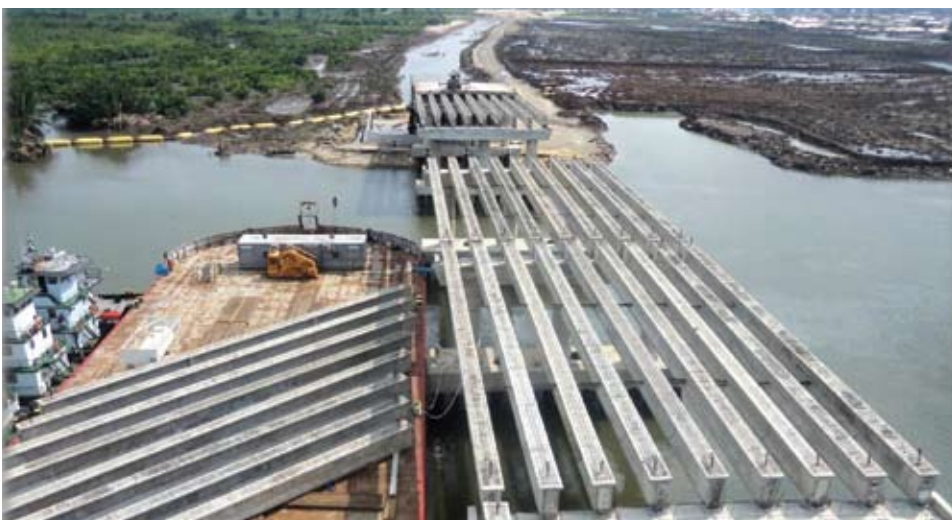
גשר אבולומה-ווג' בניגריה, שתוכנן גם הוא על-ידי "ג.א.ש הנדסת מבנים וגשרים" ובוצע על-ידי "אשטרם חו"ל", בו שימשה רפסודה בצד הגשר כפלטפורמה לנשיאת קורות וכלים מכניים כבדים
